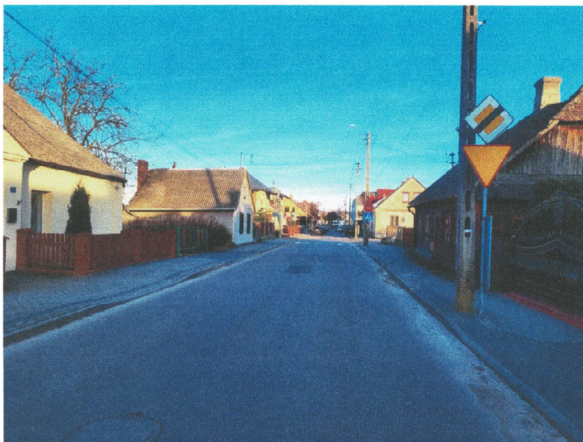
Fotografia 1 . Lokalizacja modernizowanego przejścia dla pieszych na drodze powiatowej nr 1729B . Długa prosta przed przejściem . Brak wystarczającej widoczności w prawo i lewo na skrzyżowaniu . Wskazane fizyczne wymuszenie zmniejszenia prędkości pojazdów poprzez modernizację przejścia na wyniesione przejście dla pieszych. Kierunek 1
