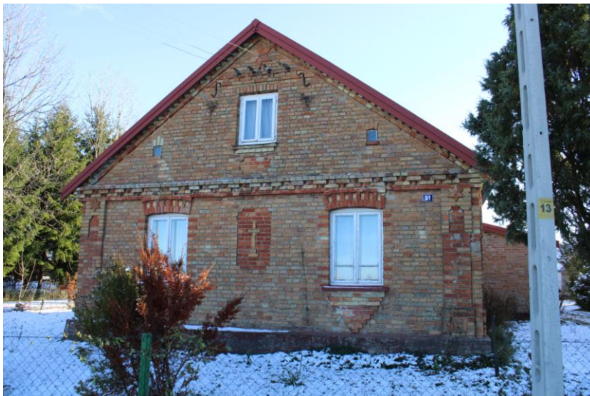
18. Dom nr 51, mur. 1900r.
