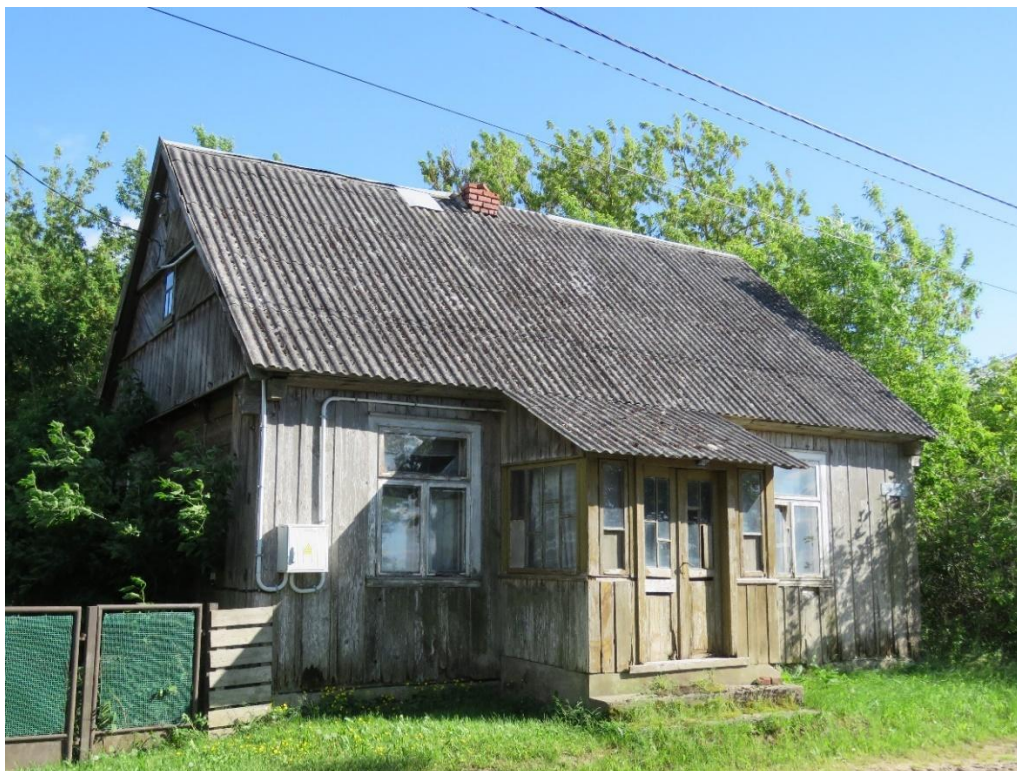
Rajgród, ul. Żabia 31 – dom drewniany z początku XX w.
