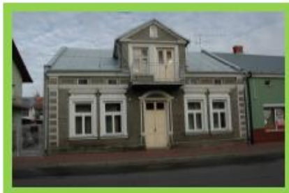
Rudnik nad Sanem - Dom, ul. Mickiewicza 29
