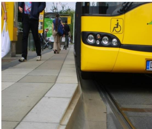
Rys. 8.6.1. Zalecane ukształtowanie krawędzi peronowej.
