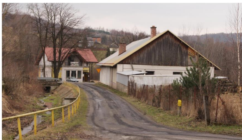
Gumniska. Dawny budynek folwarczny, ob. budynek gospodarczy.
