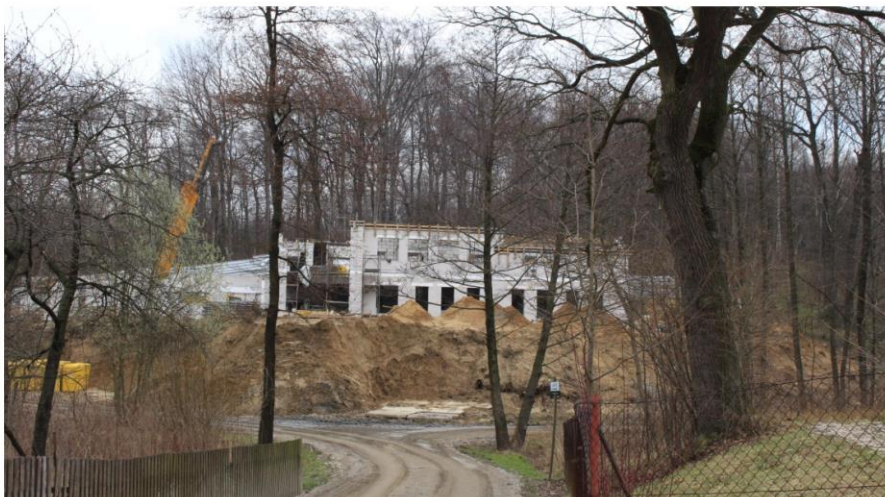
Latoszyn. Reaktywacja uzdrowiska. Budowa nowego obiektu .
