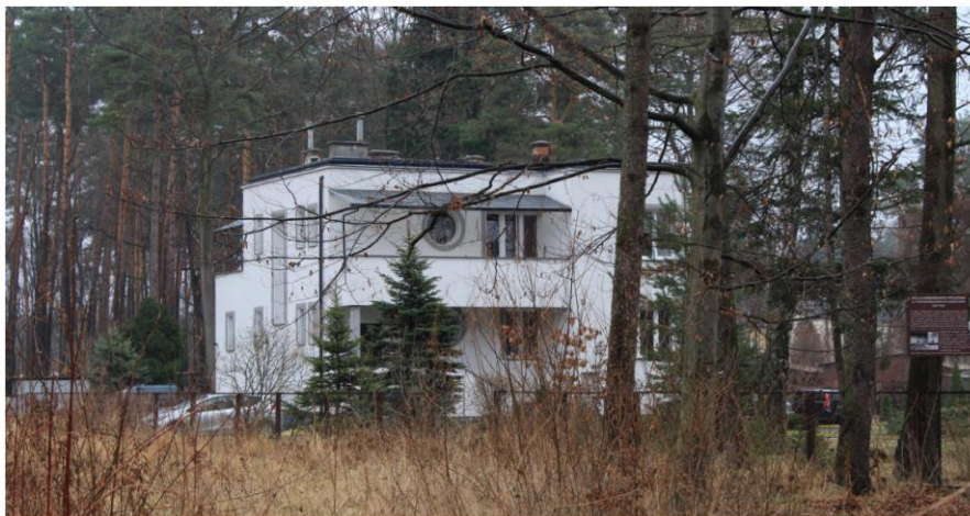
Pustków Osiedle. Założenie urbanistyczne zbudowane w ramach programu COP. Widok na willę dyrektora.
