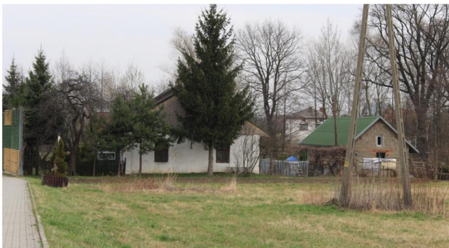
Latoszyn. Dawny zajazd przy trakcie łączącym Kraków ze Lwowem.
