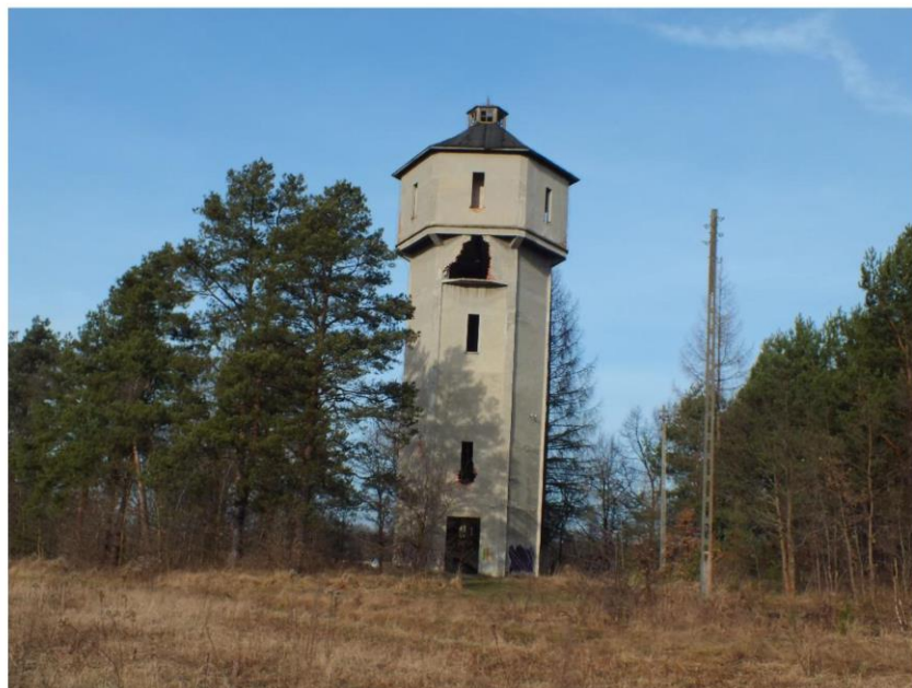
Fotografia 3 Budynek wieży ciśnieniowej w Tymcach będący w stanie degradacji
