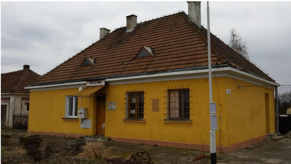
Fotografia 1 Zdegradowany budynek dworca kolejowego w Baszni
