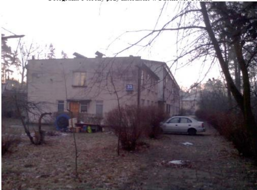
Fotografia 8 tereny przy internacie w Pustkowie Osiedlu
