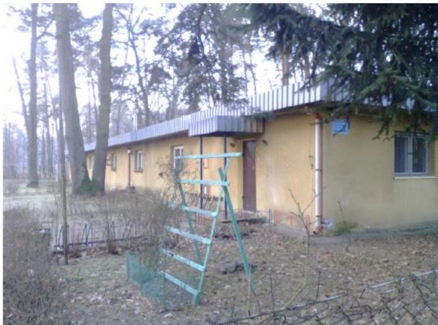
Fotografia 1 Budynek socjalny w Pustkowie Osiedlu
