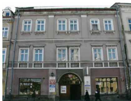
Fot. 5. Kamienica Gruszewiczów (za: GEZ)
