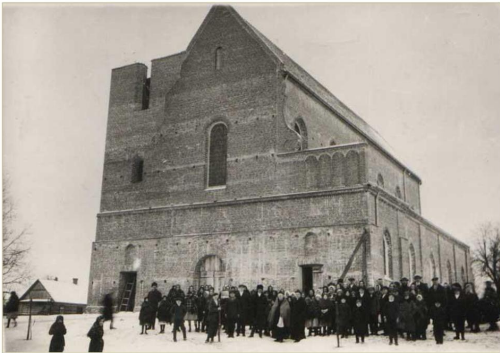
Obecny kościół paraf. w Pysznicy w budowie, fot. archi.
