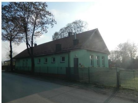
Pysznica – Budynek dawnej szkoły fot. D. Komada, 2022 r.
