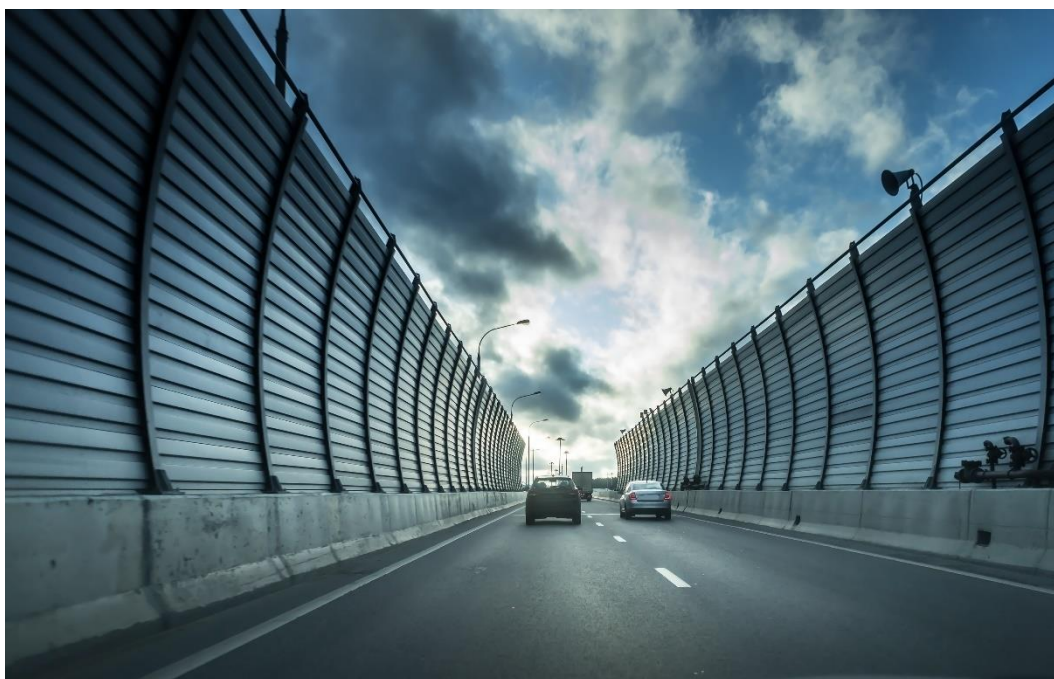
Rysunek 2.3-3 Ekran akustyczny pozwalający na istotną redukcję hałasu, trudny jednakże do zastosowania w warunkach miejskich.
