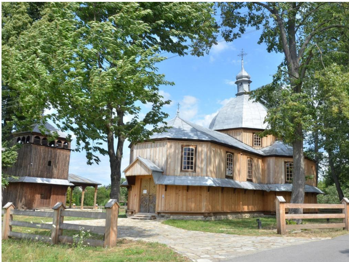
Il. 10. Odnowiona cerkiew pw. Podwyższenia Krzyża Świętego w Dachnowie po pracach remontowych w 2018 r. (Fot. K.S. 2019 r.)
