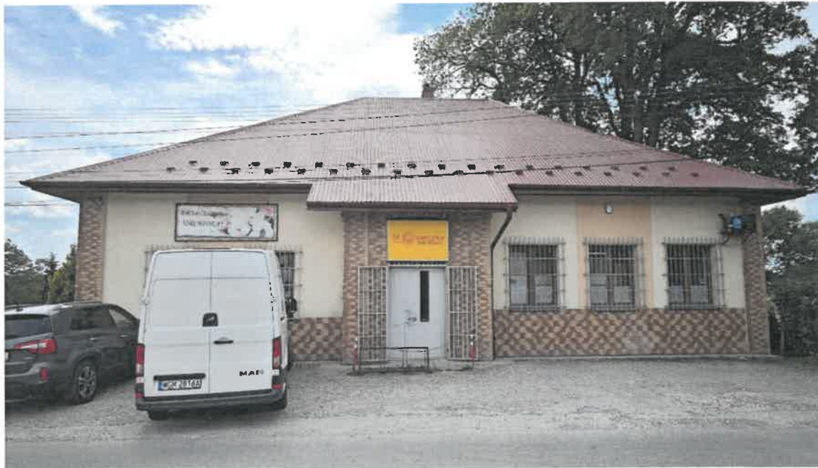
Zdjęcie 30. Budynek szkoły w Zasowie z początku XX wieku. Fot. własna, maj 2024
