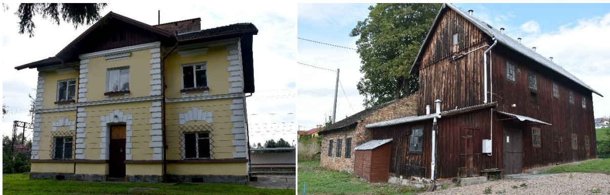
Fot. 9. Przysieki. Dworzec kolejowy oraz młyn elektryczny (fot. autor opracowania).
