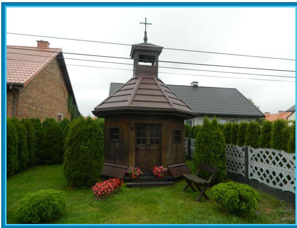
Zalesie – kaplica pw. ŚŚ. Tomasza i Zofii, fot. D. Komada, 08. 2025 r.
