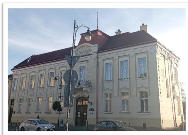
Fot. 25. Dawny budynek Rady Powiatowej (fot. Biuro ZIR)
