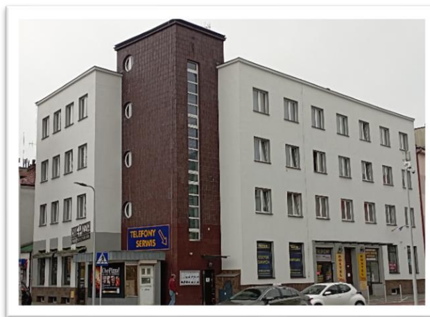
Fot. 36. Budynek dawnego Hotelu „Reichshof” (fot. Biuro ZIR)
