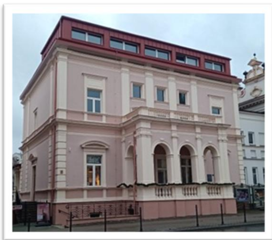
Fot. 48. Willa "Holzerówka", ul. Sokoła 7 (fot. Biuro ZIR)
