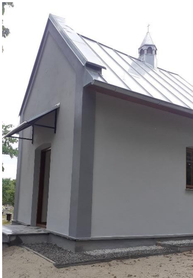
Kaplica grobowa Griesswaldów na cmentarzu parafialnym w Ślężakach
