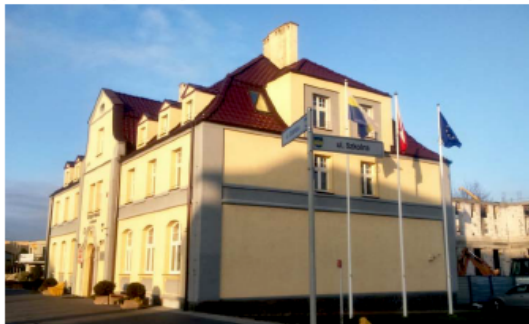
Reda, budynek dawnej szkoły, ob. siedziba Urzędu Gminy, ul. Gdańska 33.
