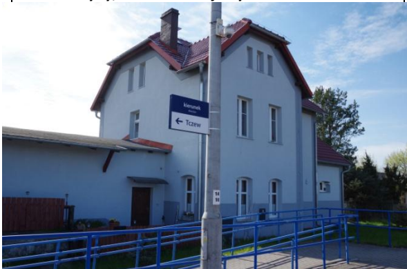
II. 50. Różyny, dworzec kolejowy
