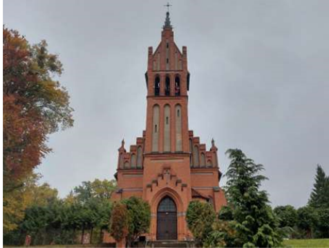
Kościół pw. Św. Rodziny i Przemienienia Pańskiego w Ryjewie – widok od południowego zachodu
