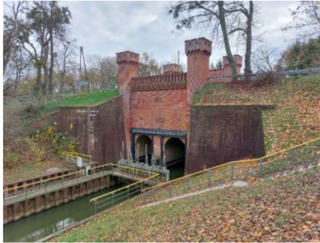
Zespół stopnia wodnego na rzece Liwie – widok na śluzę wałową od strony północno-wschodniej
