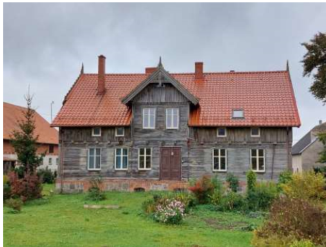
Budynek mieszkalny w Rudnikach – widok od zachodu
