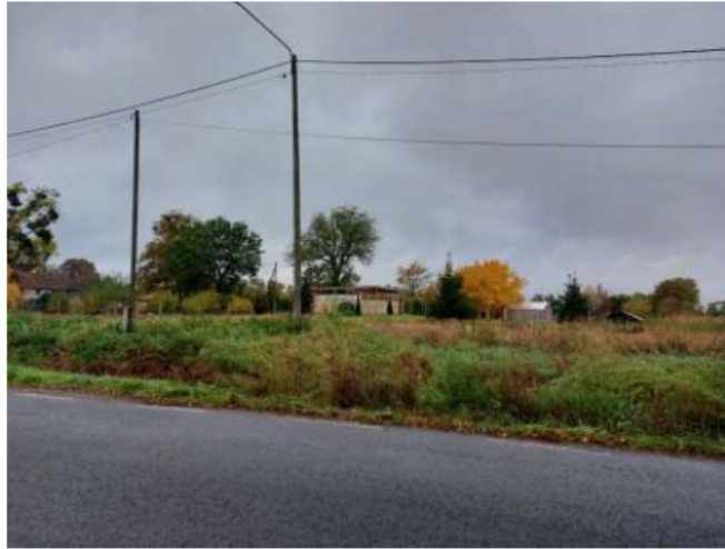
Zagroda nr 30 w Mątowskich Pastwiskach – stan obecny, widok od północnego wschodu
