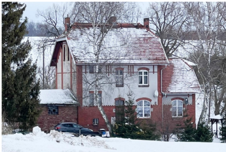
Fot . 7 Zabudowania nieczynnej stacji w Dąbrówce Bytowskiej (fot. Karina Wiśniewska)
