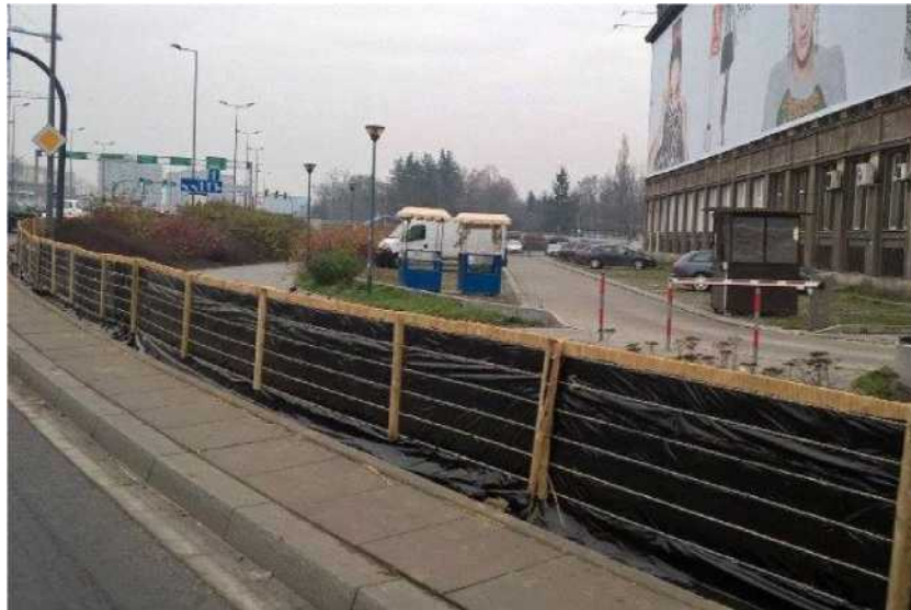
Ryc. 5 Wygradzenia przeciwsolne stosowane obecnie na terenie Gdańska
