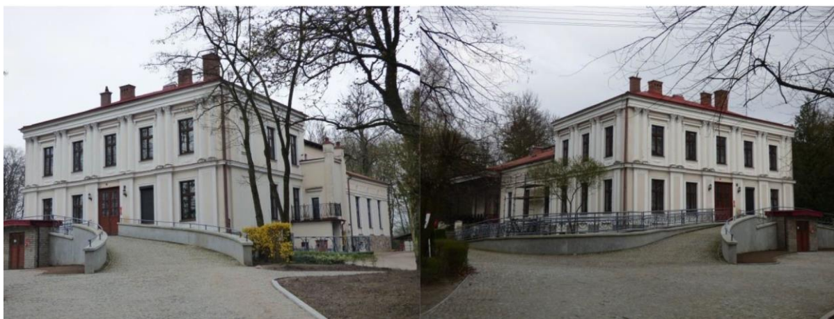
Fot. 9. Rokocin. Dwór (źródło - Gminna Ewidencja Zabytków).
