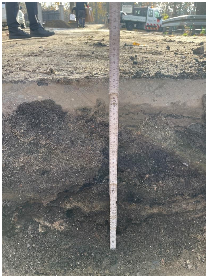
Fot. 3 Głębokość głównego wykopu - 45 cm.
