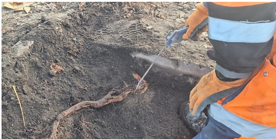
Fot. 9 Odkrywanie korzeni sprężonym powietrzem.
