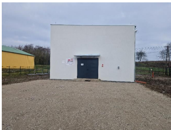
Zdjęcie nr 4 Rozbudowa i remont stacji uzdatniania wody w miejscowości Lubochowo, Gmina Stary Dzierzgoń
