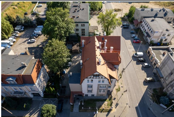
Remont dachu i elewacji frontowych
