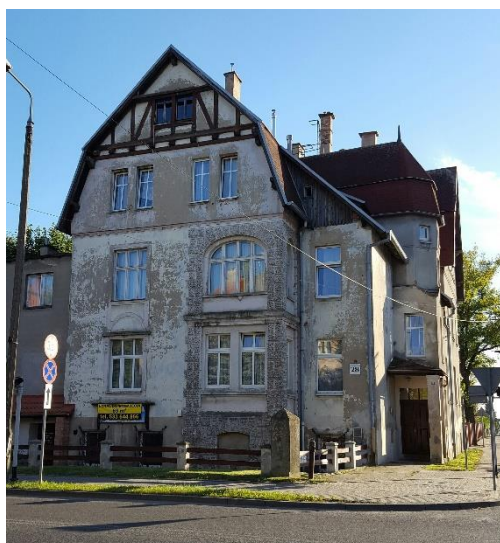
Stan obiektu przed pracami
