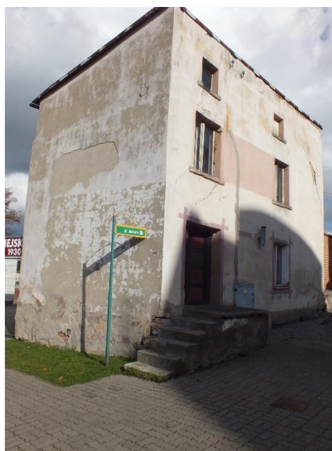
Stan przed konserwacją
