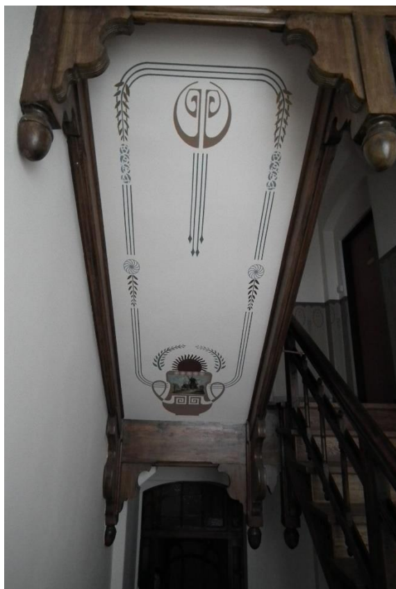
Secesyjna klatka schodowa po pracach konserwatorskich.
