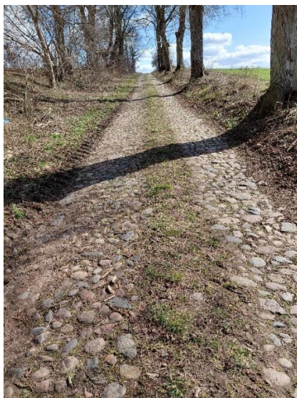
Droga brukowa w m. Wierszyno w sąsiedztwie zabytkowej gorzelni
