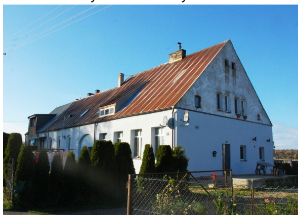
Perlino, ul. Lipowa 16-18, szkoła, ob. budynek mieszkalny
