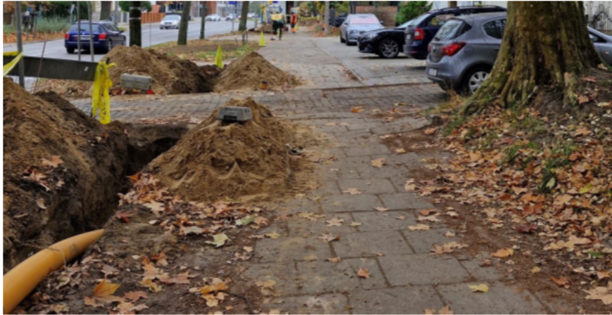
Widok wykopu pod sieć gazową w sąsiedztwie grupowego pomnika przyrody – źródło: Gdański Zarząd Dróg i Zieleni (08.11.2024)
