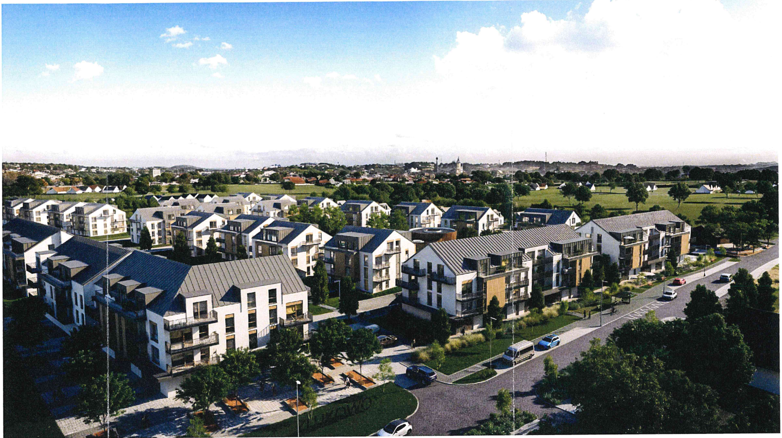
WIDOK 1 WIDOK NA BUDYNEK B3, B2, B1 OD UL. RADIOWEJ
