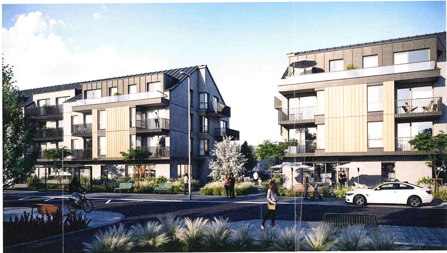
WIDOK 2 WIDOK NA BUDYNEK B1 i B2 OD UL. RADIOWEJ
