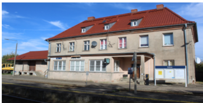
Ilustracja 141. Silno ul. Dworcowa 54a, budynek dworca.
