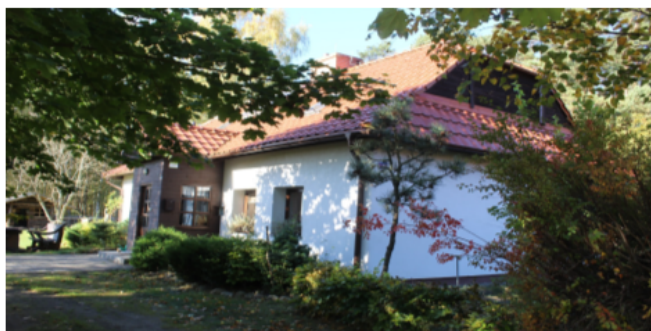
Ilustracja 143. Bachorze 4, budynek leśniczówki.
