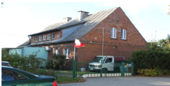
Ilustracja 135. Nieżychowice 56, budynek dawnej szkoły.
