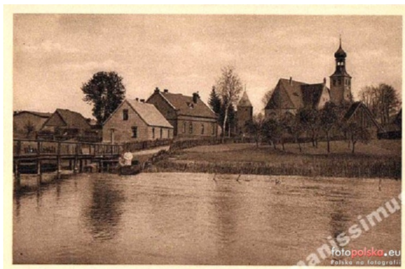
Ilustracja 36. Swornegacie Lata 1925-1935. Ulica Mestwina od strony "Koziego Mostku" nad Brdą. Zdjęcie zrobiono z ulicy Międzymostowej. Jasny budynek to ul. Mestwina nr 20, kolejny to nr 18 (plebania), pomiędzy plebanią a kościołem p/w św. Barbary widoczny "stary" drewniany kościółek, który został przeniesiony do Kaszubskiego Parku Etnograficznego we Wdzydzach Kiszewskich. Źródło: Fotopolska.
