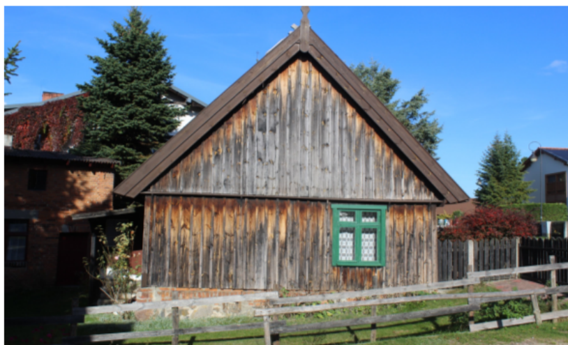
Ilustracja 52. Swonegacie ul. Mestwina 5 – charakterystyczne elementy – okna w oprawie snycerskiej, ceglany cokoł.
