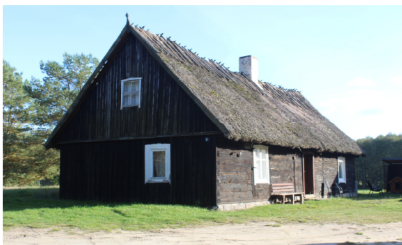
Ilustracja 50. Kamionka 1 – charakterystyczne elementy – okna w oprawie snycerskiej.
