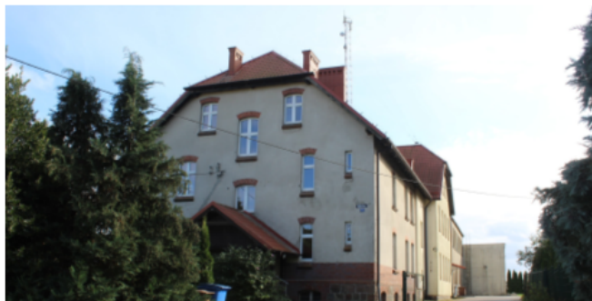
Ilustracja 138. Sławęcín ul. Szkolna 11, budynek szkoły.
