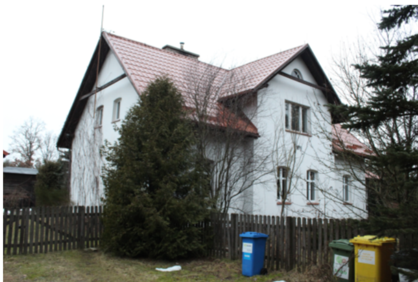
Ilustracja 150. Krojanty Wybudowania 2, budynek leśniczówki.
