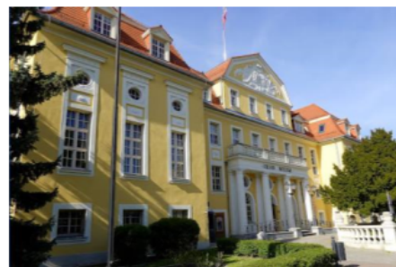
Fotografia 8. Widok na budynek Urzędu Miejskiego w Kwidzynie.
