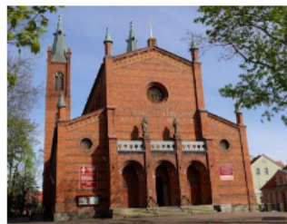
Fotografia 2. Widok na Kościół pw. św. Trójcy, przy ul. Piłsudskiego 47.
