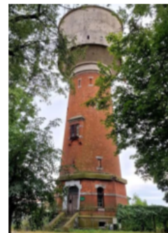
Fotografia 20. Widok na dawną wieżę ciśnień przy ul. Sportowej.
