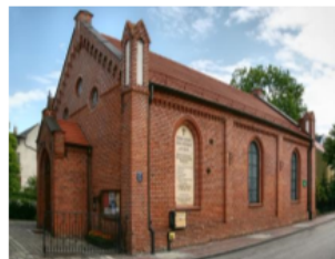
Fotografia 4. Widok na dawną kaplicę Kościoła Ewangelicko-Metodystycznego.
