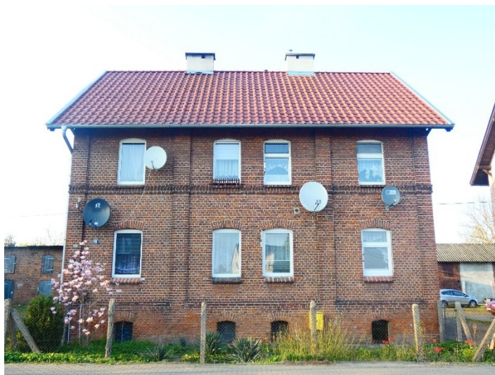
Fot. 7. Dom przy ul. Dworcowej w Subkowach z 1900 roku
