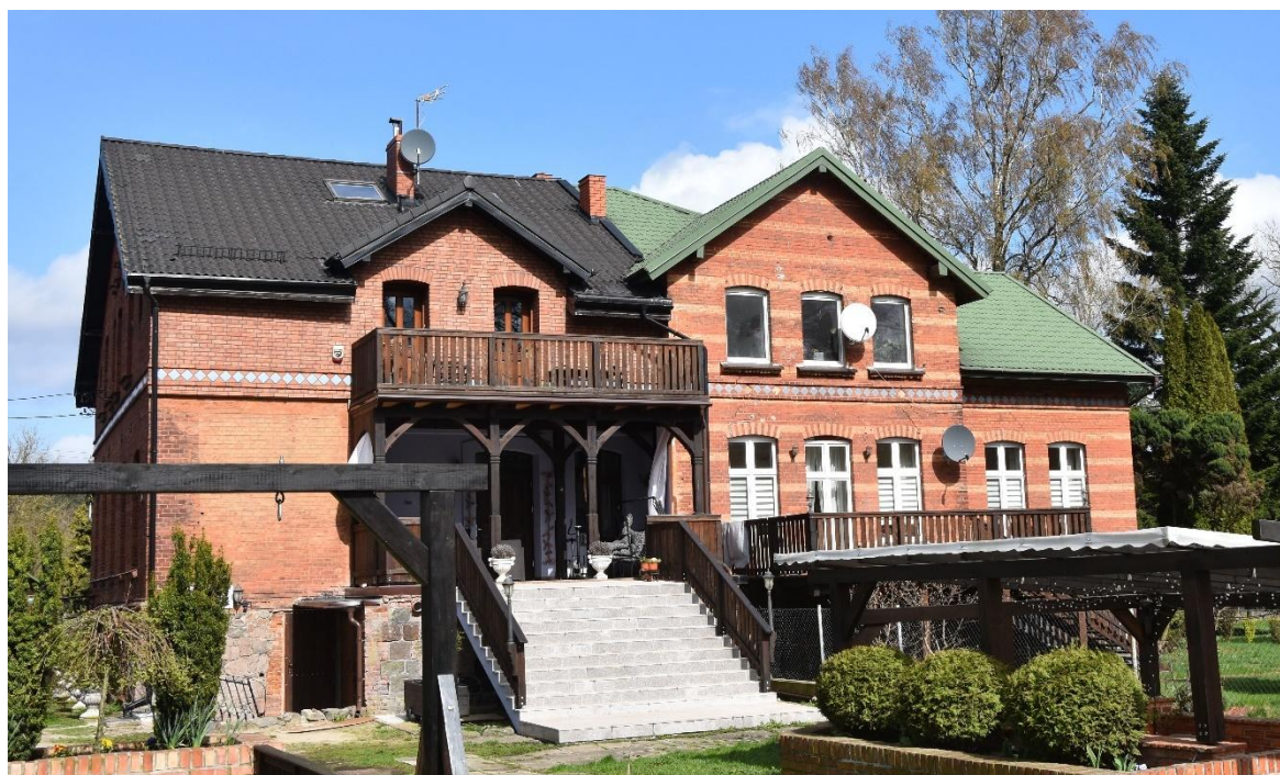
Fot. 3. Reda – Pieleszewo. Budynek dawnego dworu, ul. Reczna 2 (fot. autor opracowania).
