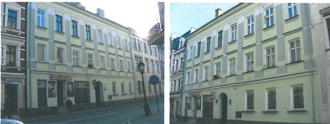
Zdjęcie nr 18 i 19. Budynek Sienkiewicza 3 – elewacja zachodnia. Wymagany remont elewacji wschodniej:
