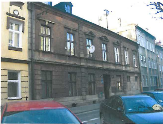
Zdjęcie nr 27, 28. Budynek Jagielly 22 – wymagany remont:
