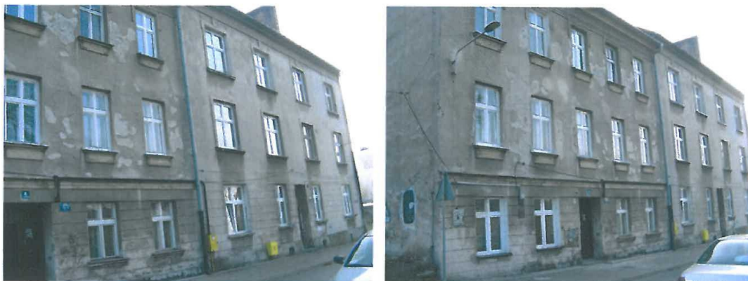
Zdjęcie nr 31, 32. Budynki Krasickiego 4 i 6 – wymagany remont:
