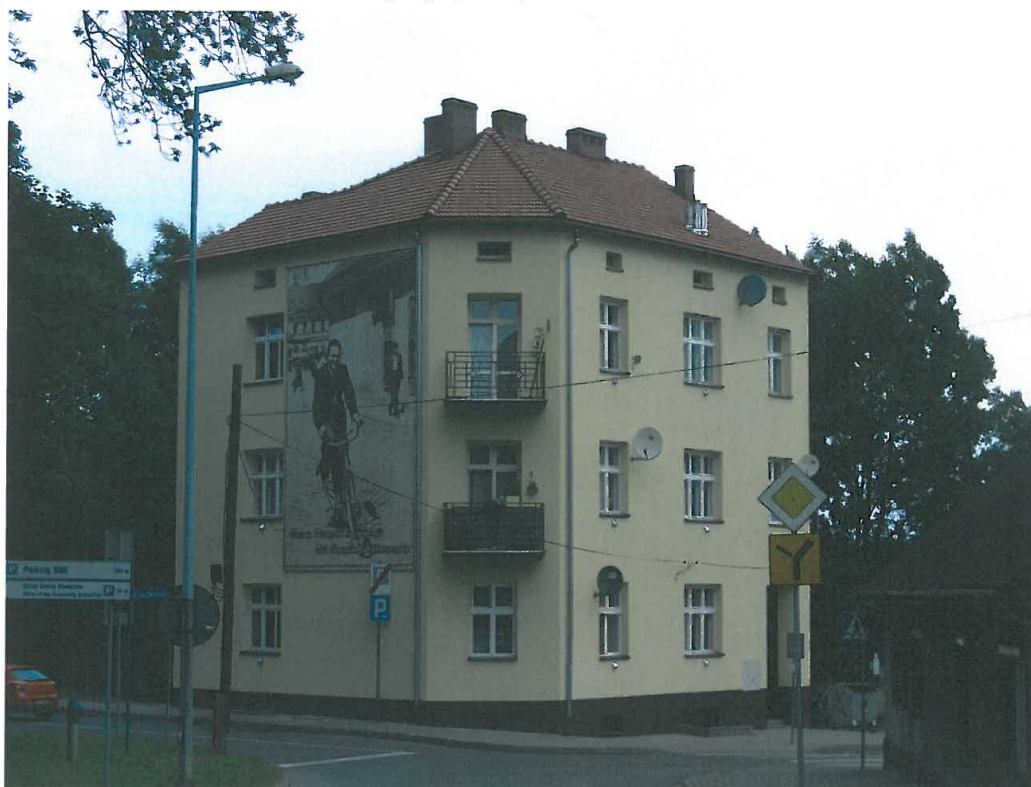
Zdjęcie nr 33. Budynek ul. Zamkowa 3 – wymagany dalszy remont:
