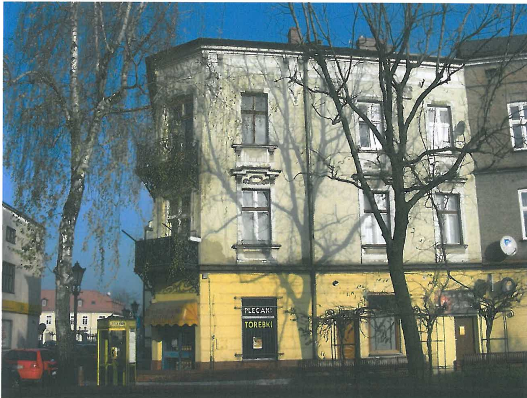
Zdjęcie nr 13, 14, 15. Budynek Mickiewicza 2 – wymagający remontu:
