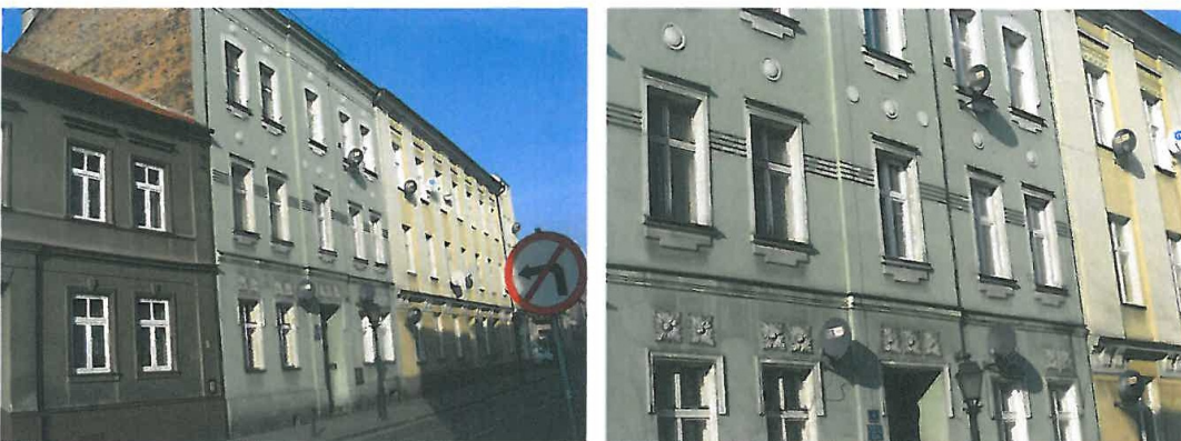
Zdjęcie 20, 21, 22. Budynek Sienkiewicza 4 – wymagany remont:
