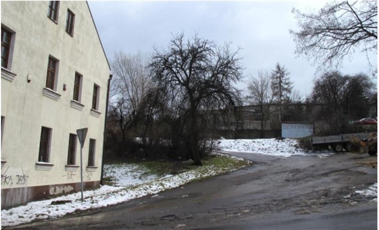
Podobszar 2 - obiekty mieszkalne przy ul. Kłaśnieńskiej.
