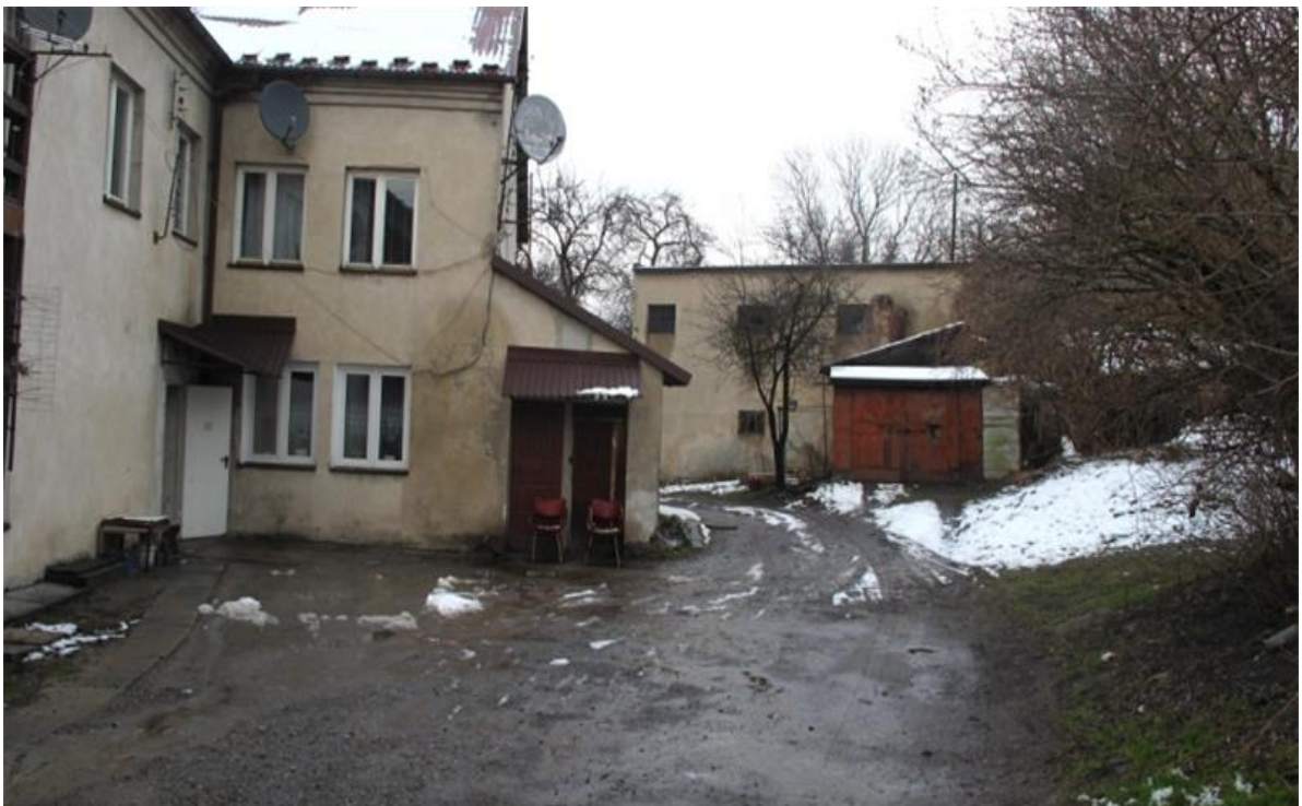
Podobszar 2 - budynek mieszkalny przy ul. Kłaśnieńskiej.
