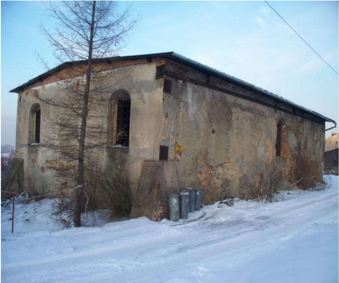
Podobszar 2 - budynek byłej synagogi ul. Kłaśnieńskiej.
