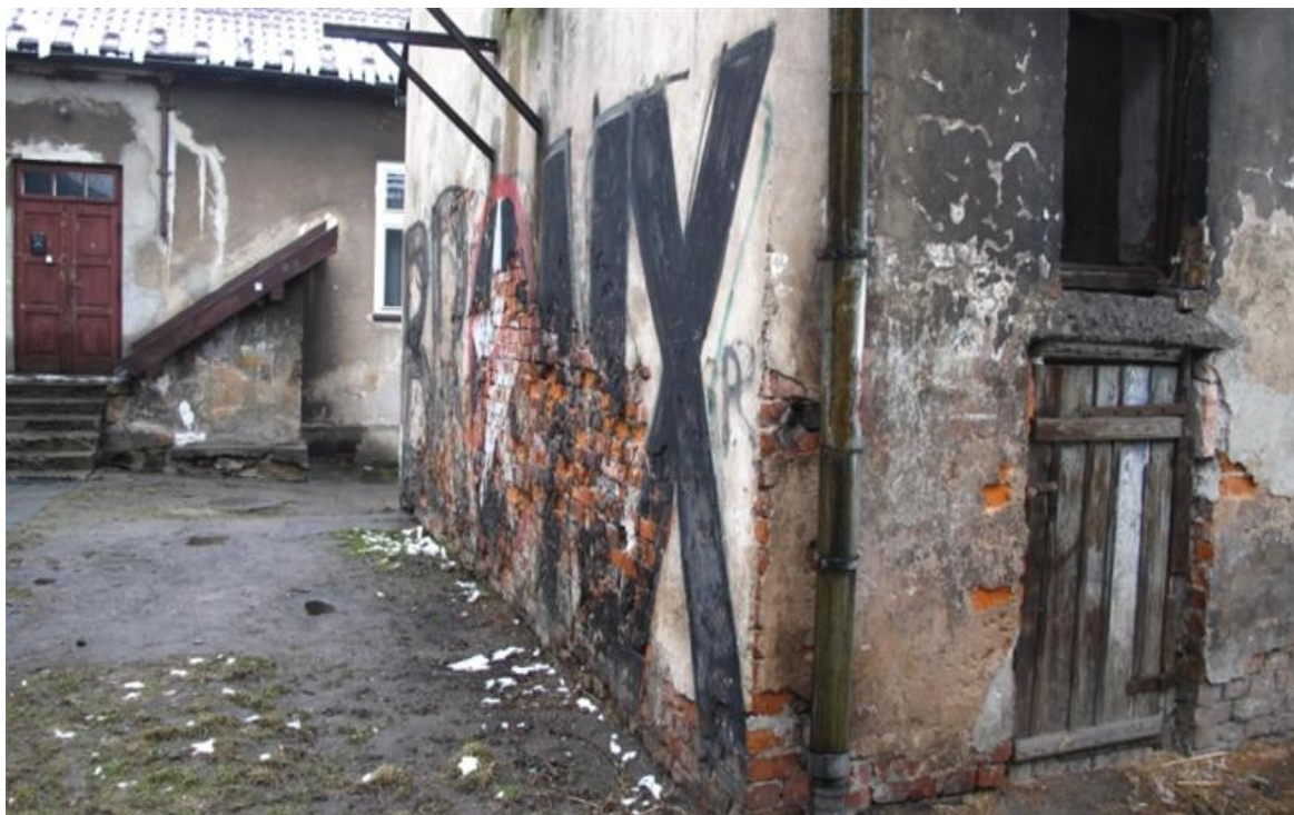
Podobszar 4 - budynki gospodarcze przy budynkach socjalnych.
