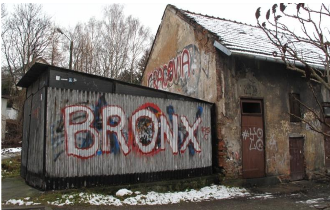
Podobszar 4 - budynki gospodarcze przy budynkach socjalnych.
