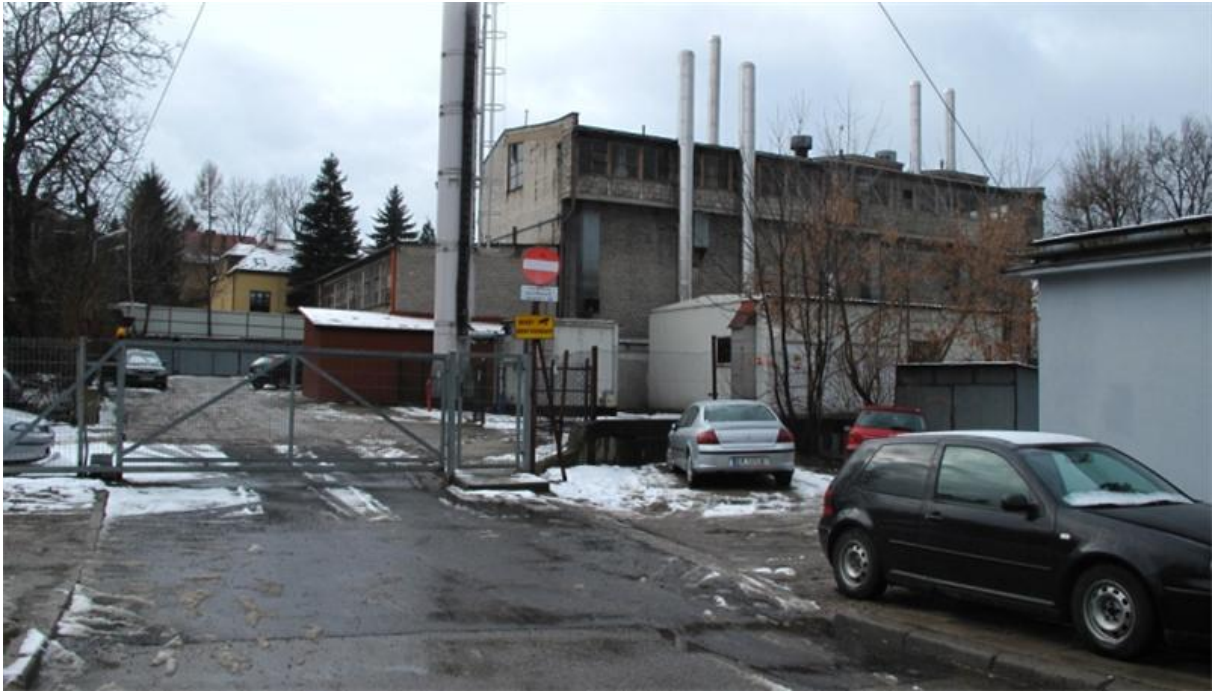
Podobszar 1 - teren nieczynnej ciepłowni wraz z opuszczonymi obiektami.
