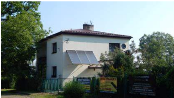
Fot. 1. Zabudowa mieszkaniowa, Skrzydlna
