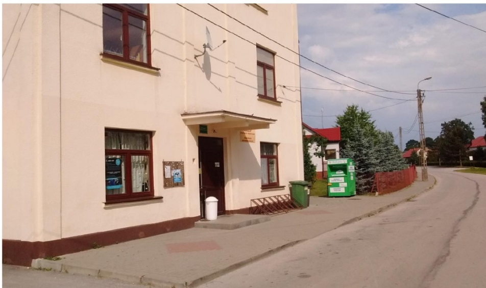
Fotografia 6 Budynek Domu Ludowego i siedziby OSP w Miechowicach Wielkich
