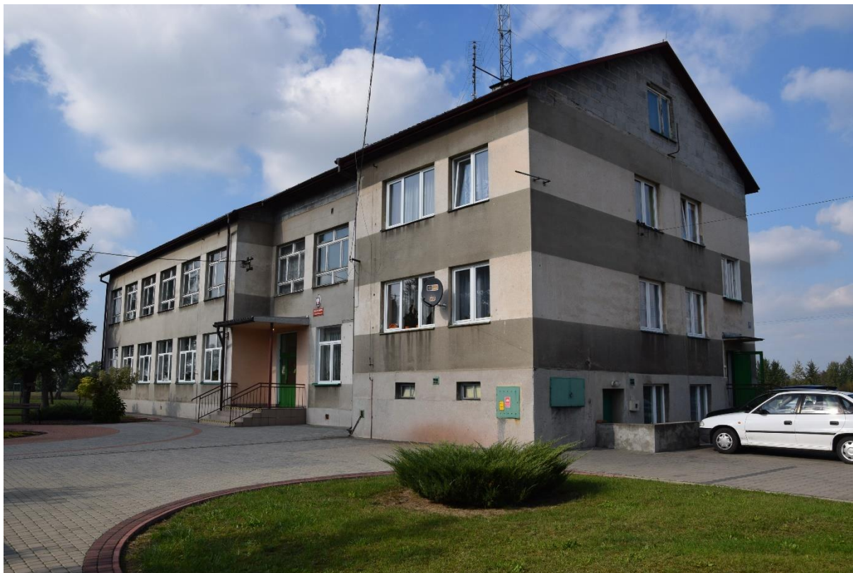
Fotografia 8 Zdegradowany budynek szkoły – Lęg
