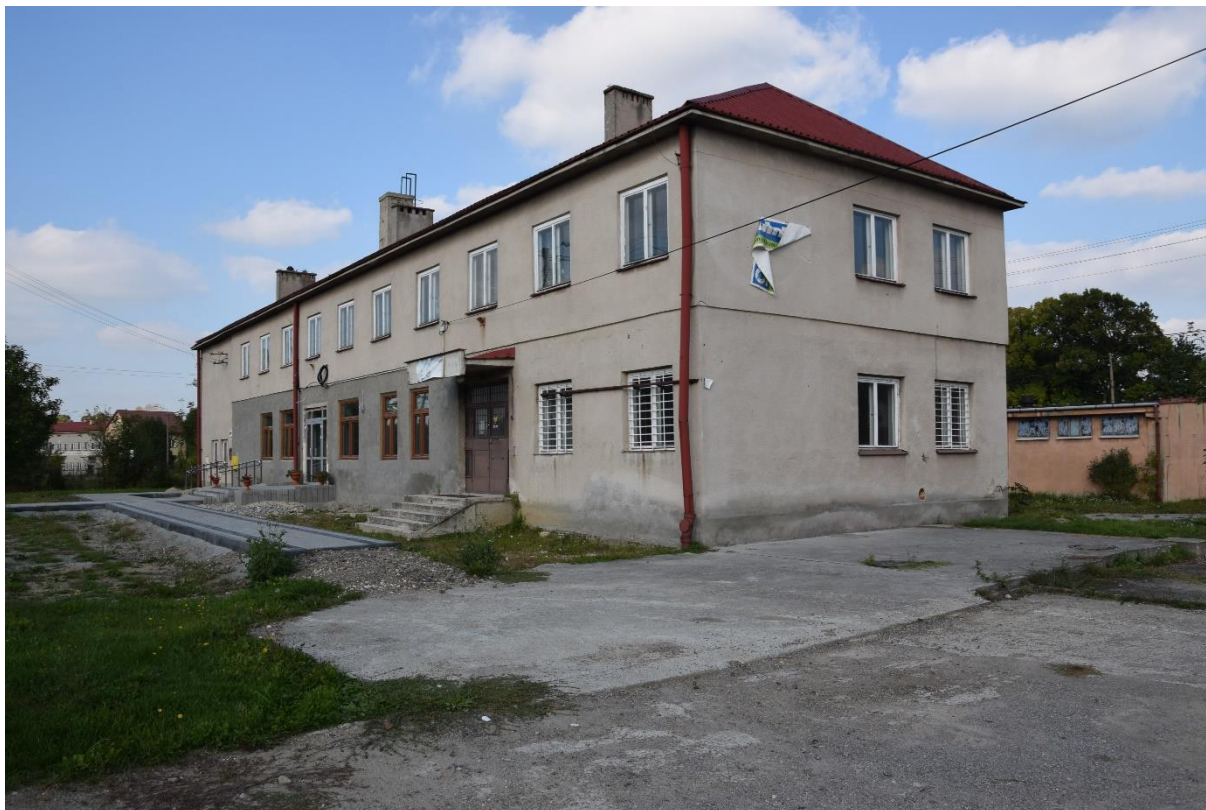
Fotografia 5 Zdegradowany budynek po byłej Spółdzielni w Radgoszczy I
