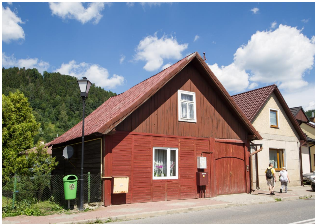
Ryc. 11 - Budynek mieszkalny przy ul. Kościelnej 27 w Muszynie
