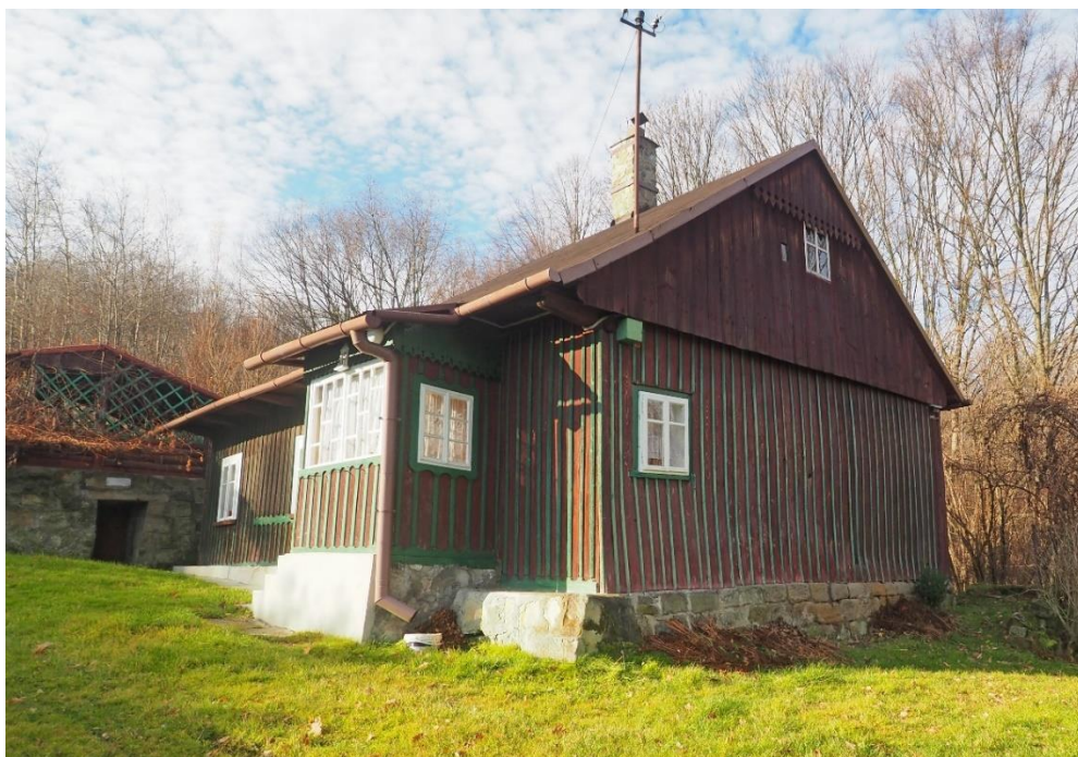
Ryc. 19 Przykład tradycyjnej zabudowy drewnianej w Biertowicach na podmurówce, dom oszalowany, z charakterystycznymi ostrymi fryzami
