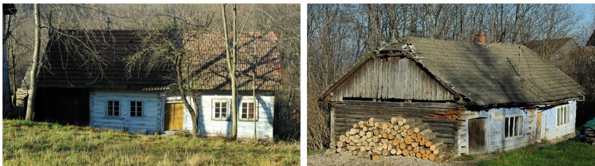
Ryc. 11 Przykładowe budynki z połączoną częścią mieszkalną z częścią gospodarczą w Harbutowicach
