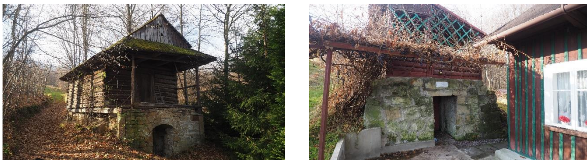
Ryc. 14 Przykłady podpiwniczonych spichlerzy w Biertowicach Źródło: fot. Magdalena Fajkosz
