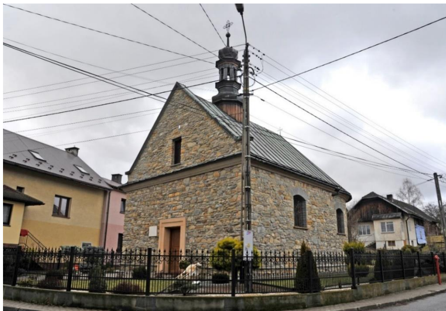
Ryc. 36 Kaplica pw. św. Zofii w Sulkowicach Źródło: fot. Katarzyna Michniowska
