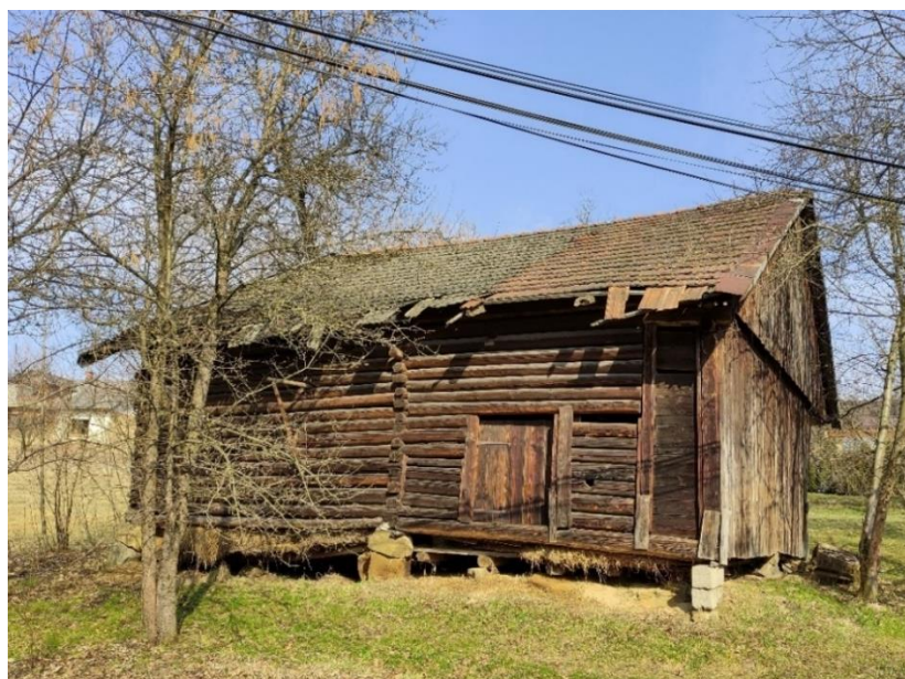
Ryc. 12 Przykład tradycyjnej zabudowy gospodarczej drewnianej z posadowieniem na kamieniach – stodoła – Rudnik, ul. Bukowa
