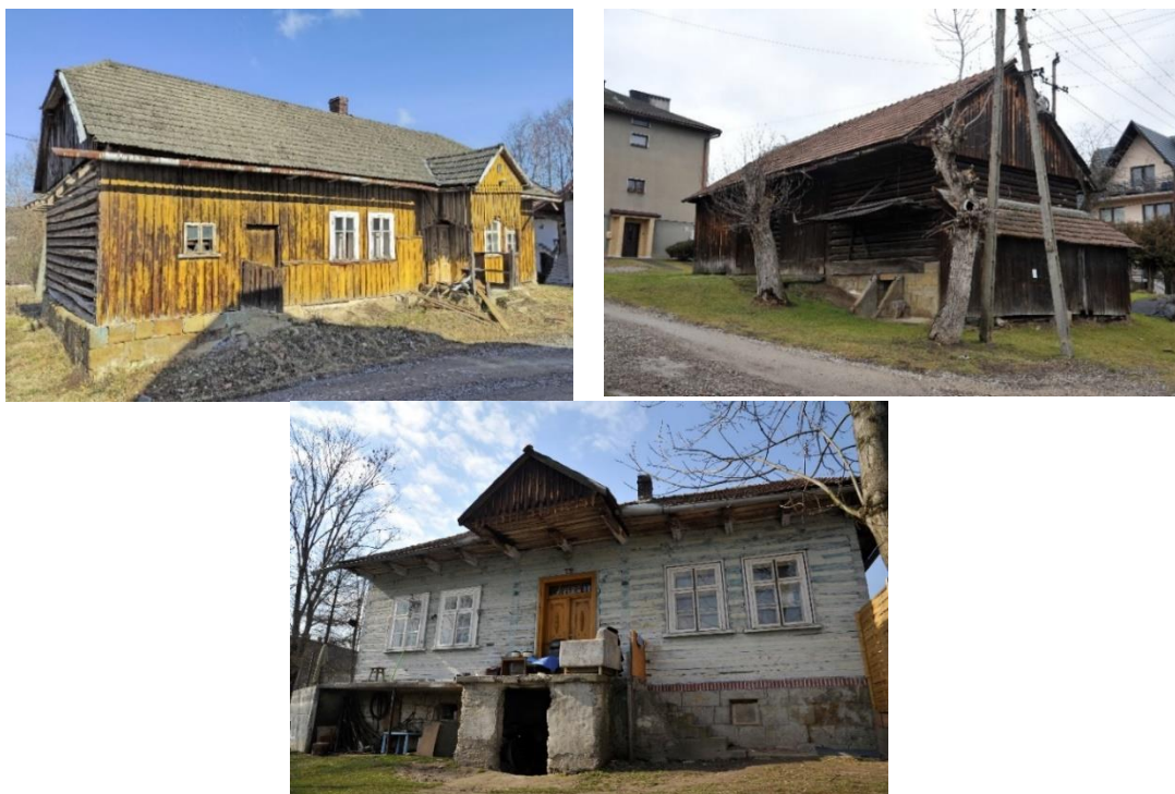
Ryc. 16 Przykład zabudowy drewnianej na podmurówce (Rudnik) oraz zabudowy z podpiwniczeniem (Sułkowice)
