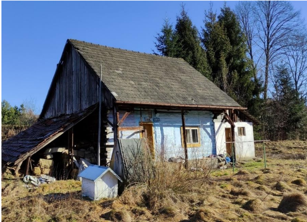
Ryc. 15 Budynek mieszkalny wzniesiony w konstrukcji przysłupowej w Rudniku Źródło: fot. Jakub Suszek
