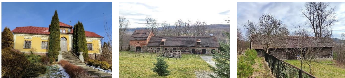
Ryc. 30 Zespół plebański przy kościele parafialnym pw. Trójcy Przenajświętszej w Krzywaczce (plebania, budynek inwentarski, stodoła)
