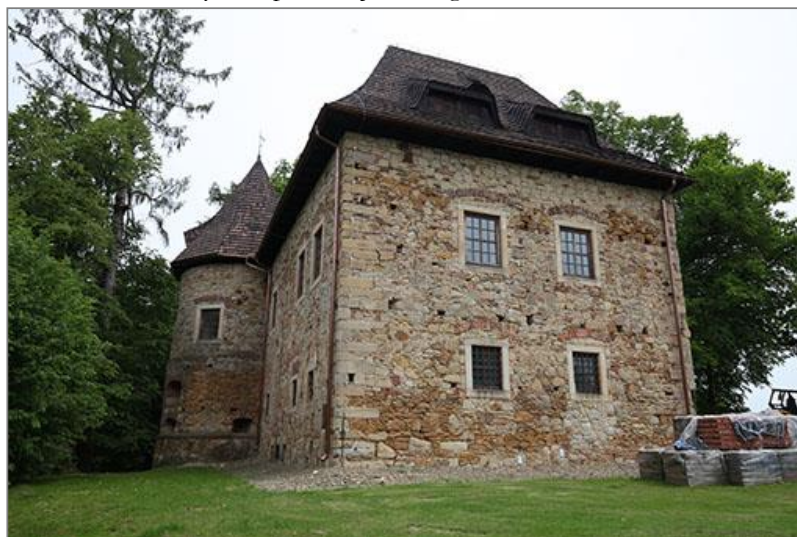
Fotografia 13. Dwór obronny w Wieruszycach, budowany w pierwotnej formie do 1531 r., obecny - wybudowany na przełomie XVI i XVII w. [źródło: archiwum własne 2020 r.]
