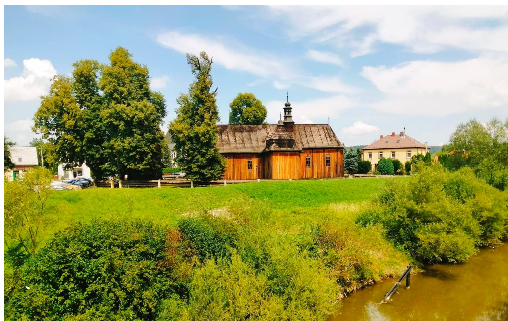
Fotografia 17. Kościół św. Bartłomieja w Łapanowie. Niegdyś główne wejście na teren kościoła zlokalizowane było od strony rzeki Stradomki - to tutaj, po obu stronach furtki posadzono lipy drobnolistne [źródło: archiwum własne 2022 r.]
