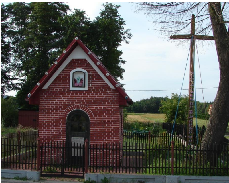
Kapliczka domkowa oraz drewniany krzyż w Gruszowie Wielkim
