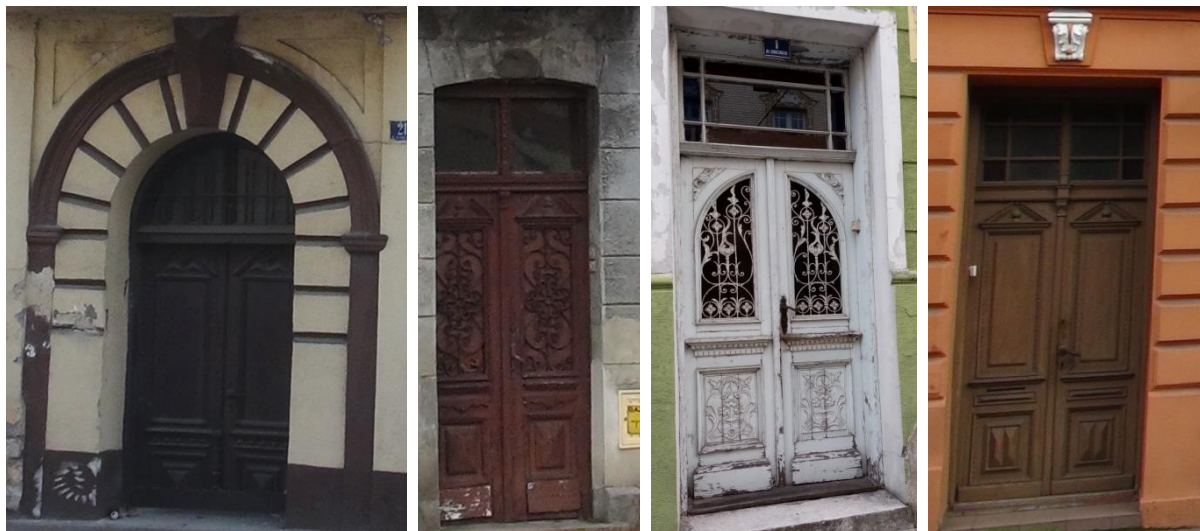
Bramy i drzwi do budynków przy ul. Głowackiego 21, Rynek 7, ul. Sobieskiego 1, ul. Mickiewicza 4.
