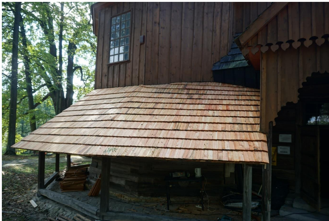
Kościół pw. Św. Andrzeja w trakcie prac wymiany gontu nad sobotami
