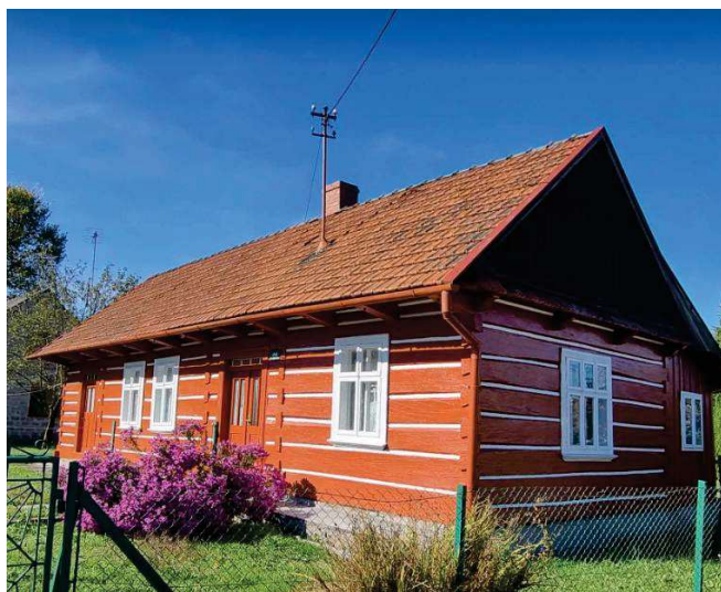
Fotografia 11. Budynek mieszkalny w Borku.
