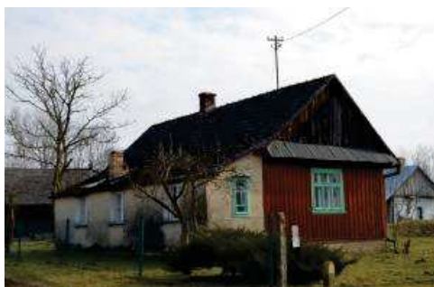
Fotografia 10. Widok na dom – Borek 106.
