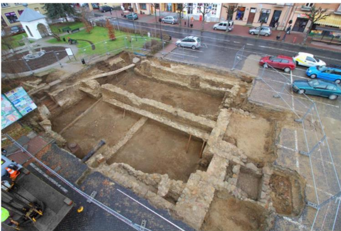
Ryc. 5. Widok z lotu ptaka na oczyszczone piwnice biskupie
