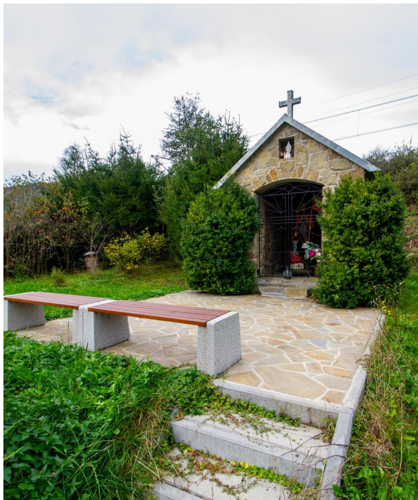
Ryc. 32. Kapliczka św. Floriana w Muszynie po pracach renowacyjnych (stan na 2024 r.)
