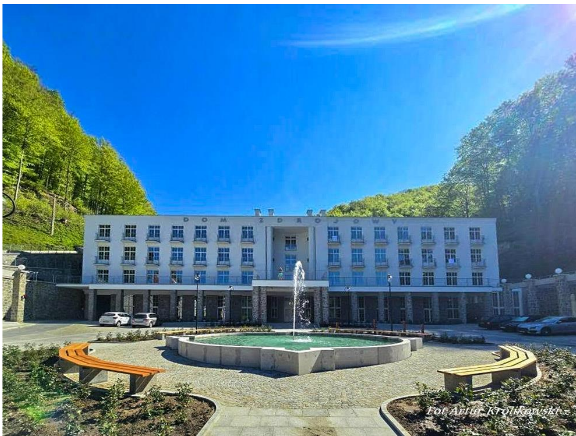
Ryc. 64. Sanatorium "Dom Zdrojowy" po zakończonych pracach remontowych (stan na 2025 r.)
