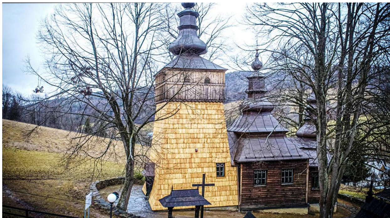
Ryc. 58. Cerkiew w Wojkowej po pracach renowacyjnych. Stan na 2025 r.
