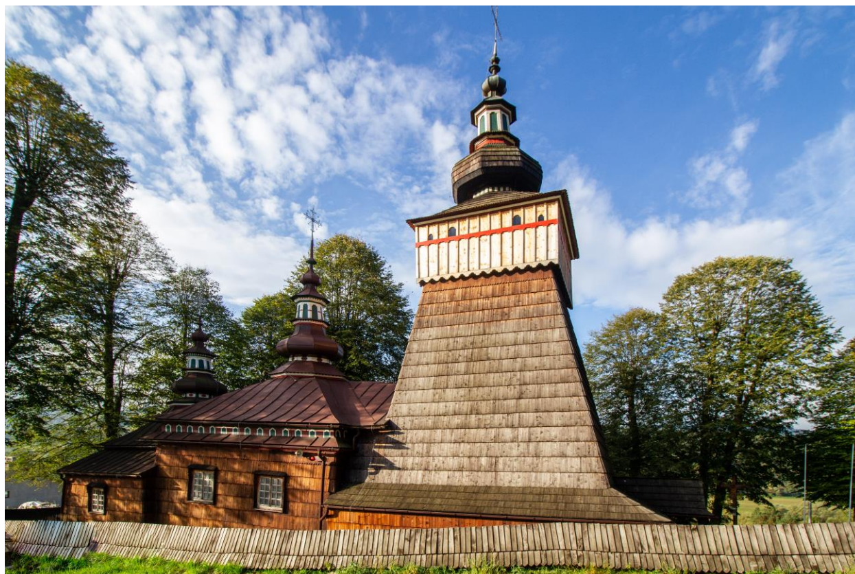
Ryc. 25. Cerkiew w Andrzejówce po pracach renowacyjnych (stan na 2024 rok.)
