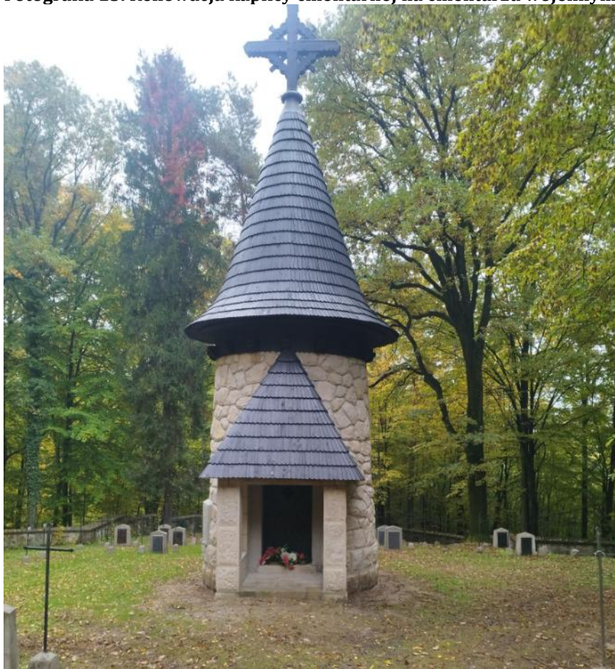
Fotografia 15. Renowacja kaplicy cmentarnej na cmentarzu wojennym Nr 301 w Leszczynie
