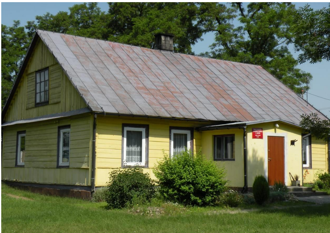
99. Dawna Szkoła Podstawowa w Dębicy. Obecnie świetlica. Fot. A. Małecki 2009 r.
