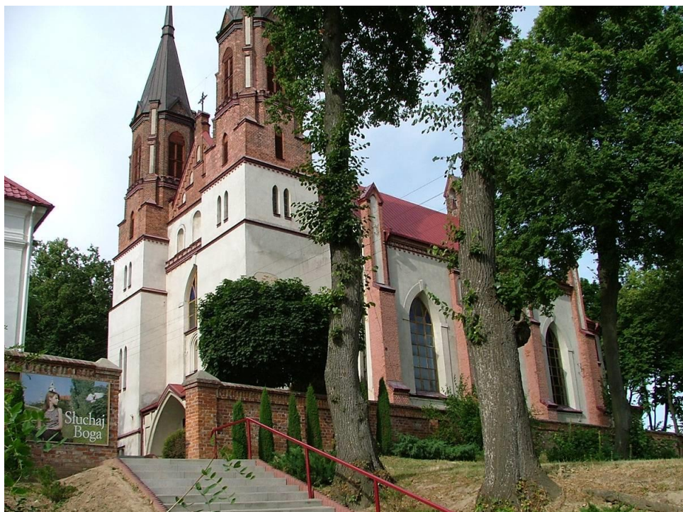
50. Kościół parafialny w Klementowicach. Fot. A. Małecki 2009 r.
