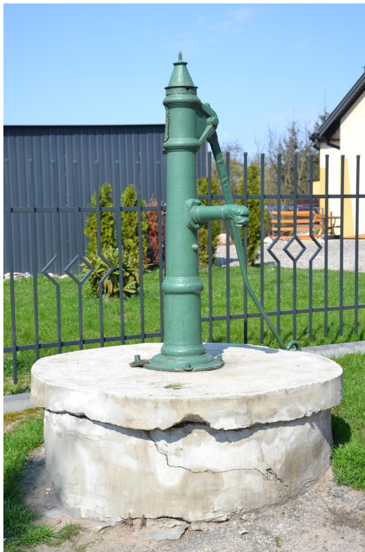
96. Studnia na pompę ul. Kowalska. Fot. A. Małecki 2017 r.
