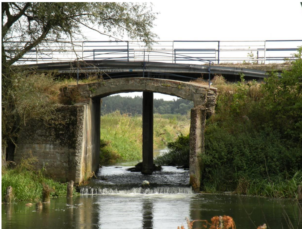
97. Most łukowy z 1905 r. na drodze gminnej relacji Brzozowa Gać – Wólka Nowodworska. Fot. A. Małecki 2009 r.
