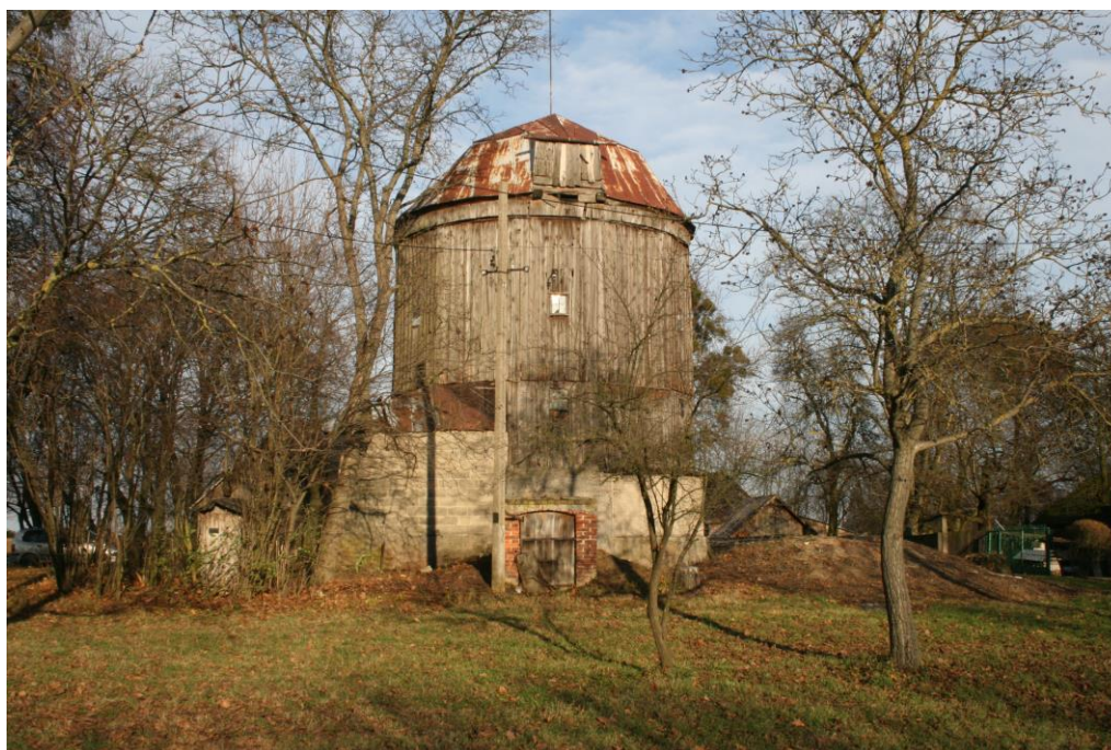
Wiatrak w Klementowicach. Fot. Zbigniew Zacharski Gminna Ewidencja Zabytków 2016
