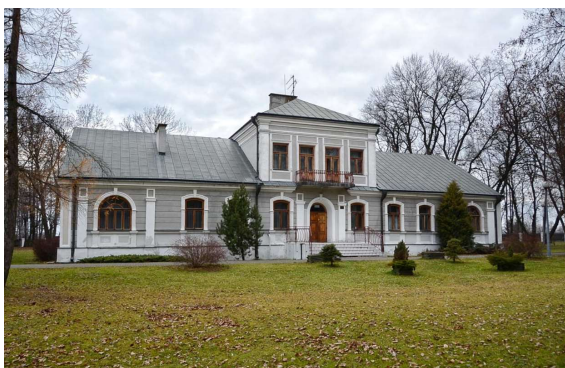
Fot. 9 i 10. Dwór w Grabanowie – elewacja frontowa i tylna.
